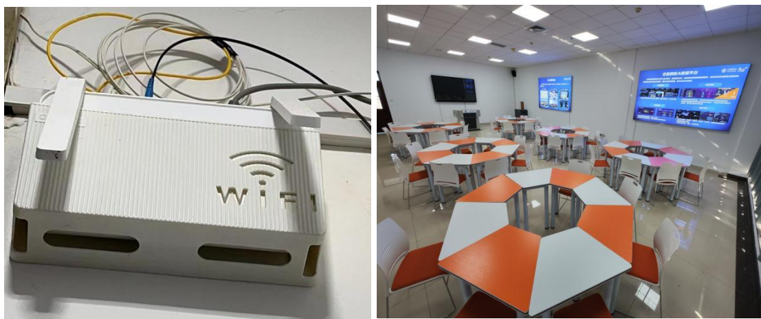
图 1-20 5G 信号室分、应用实训室
